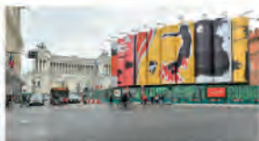
Cantiere stazione Venezia
